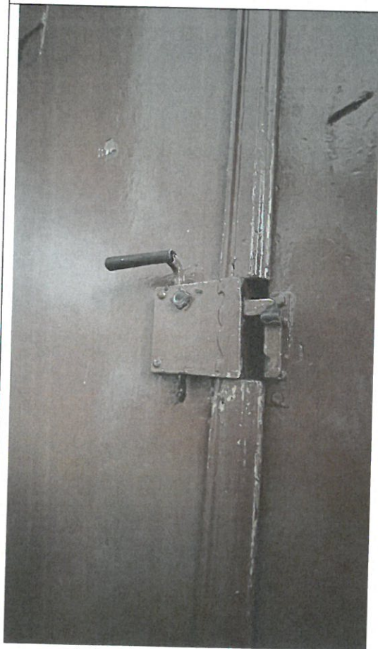
Fot. 13 Zakrystia – drzwi wewnętrzne dwuskrzydłowe pomiędzy salkami – klamka z zamkiem
