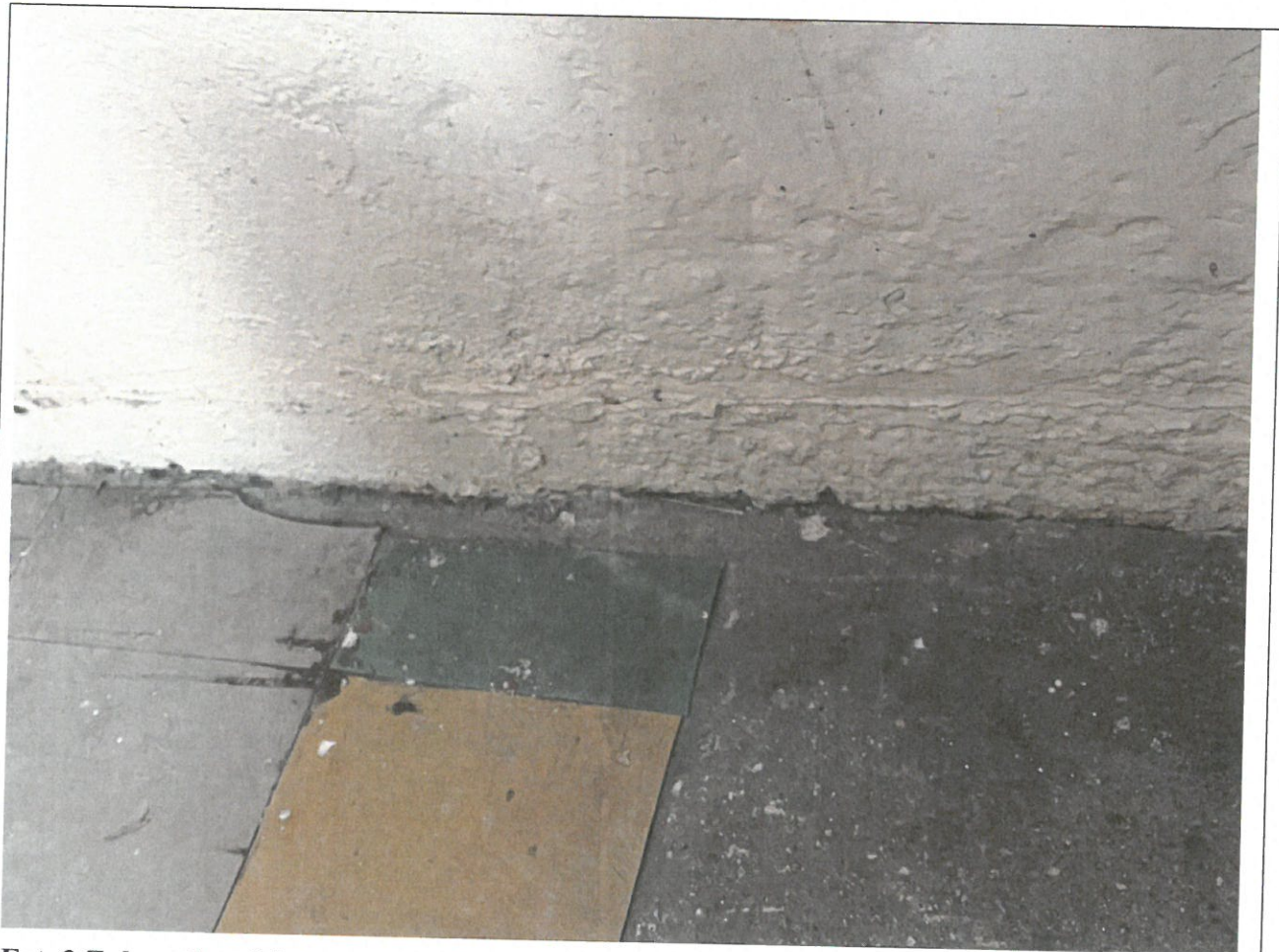
Fot. 3 Zakrystia – faktura tynku ściany
