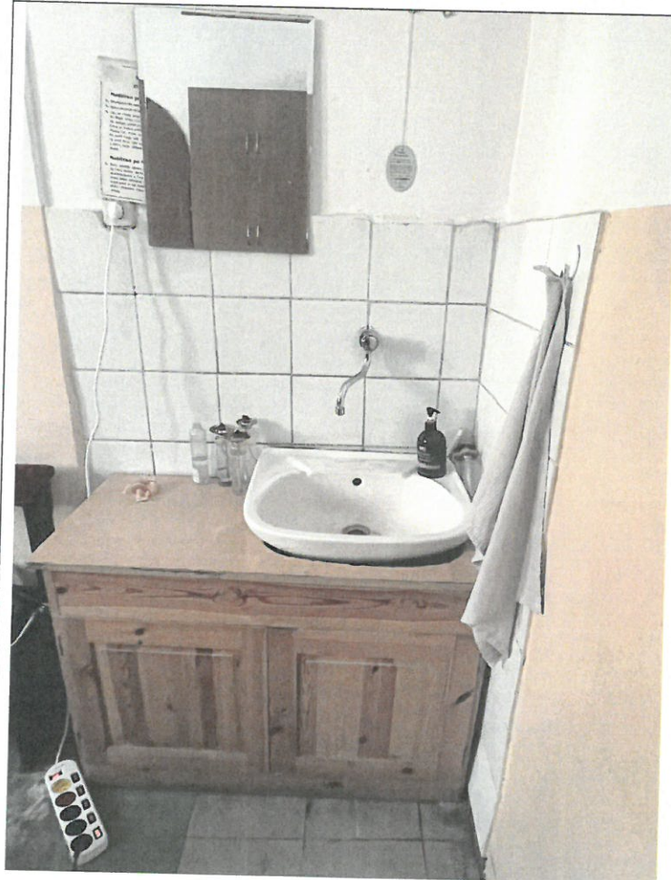
Fot. 4 Zakrystia – lamperia oraz okładzina ściany z płytek glazurowanych
