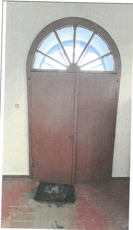
Fot. 11 Zakrystia – drzwi wewnętrzne dwuskrzydłowe przed drzwiami zewnętrznymi
