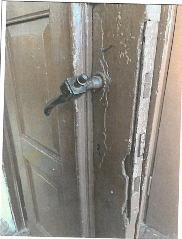
Fot. 15 Zakrystia – drzwi wewnętrzne dwuskrzydłowe pomiędzy salkami – klamka wraz z zamkiem
