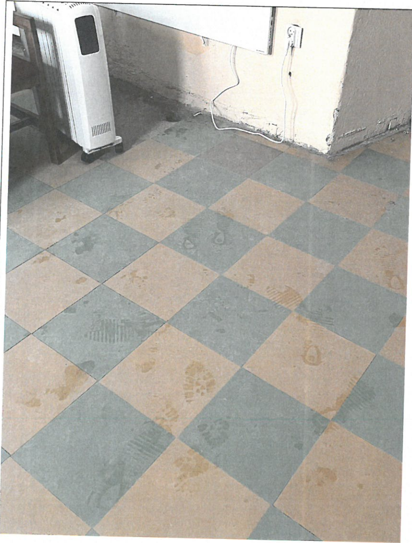
Fot. 22 Zakrystia – płytki linoleum na posadzce lastrykowej
