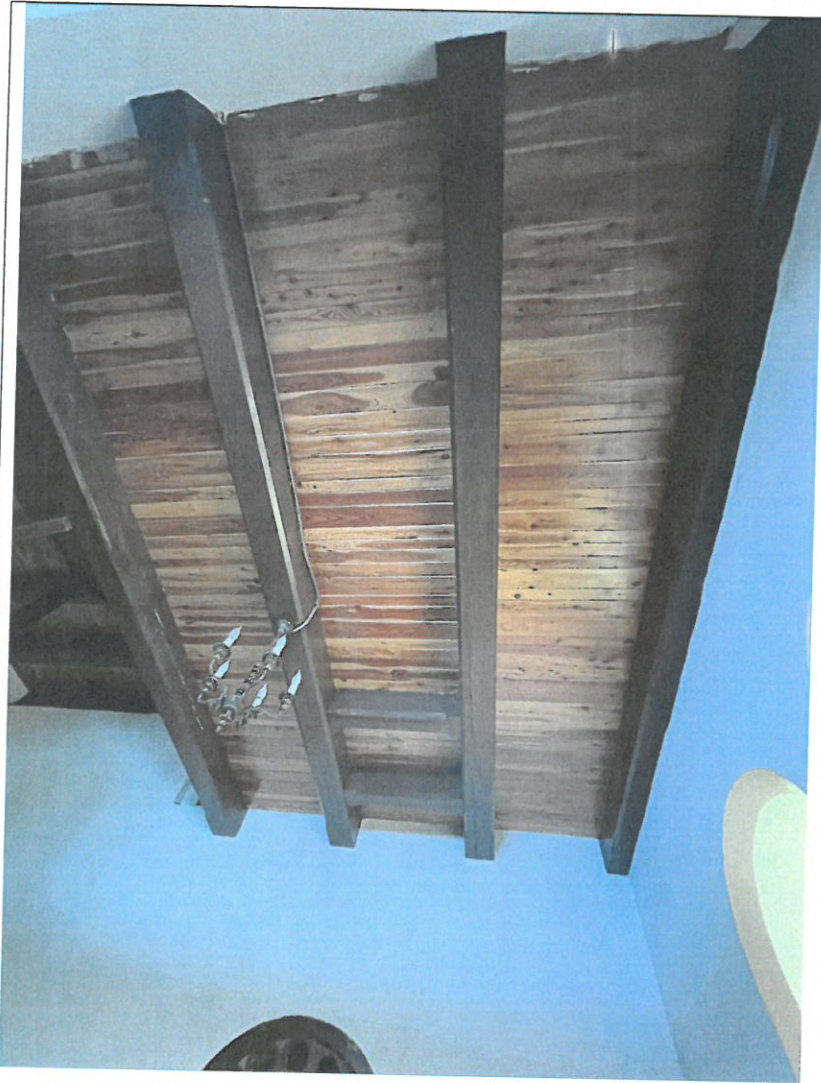
Fot. 20 Przedśionek prawy – drewniany strop belkowy
