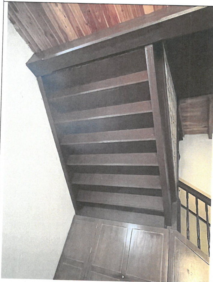
Fot. 19 Przedsiónek prawy – schody drewniane – widok na od spodu na bieg schodowy oraz widoczna współczesna ściana drewniana schodów
